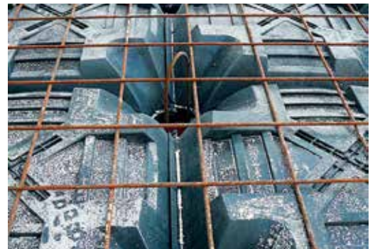
U donatı ile sütunların güçlendirilmesi
